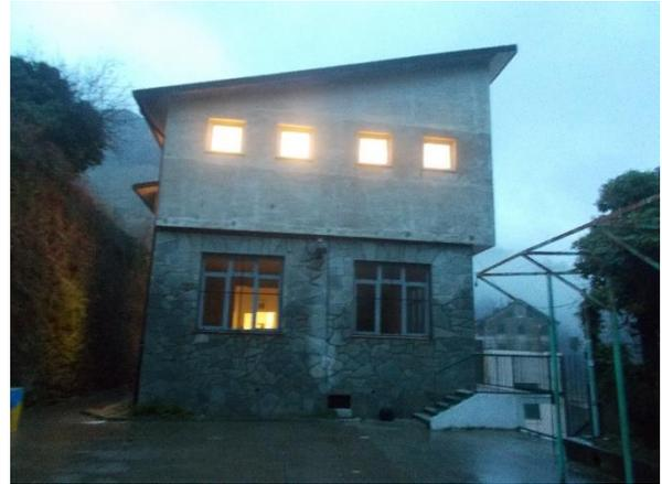
Il comportamento termico dell'edificio è in gran parte dovuto alla sua morfologia: pareti di spessore notevole e copertura non isolata.
